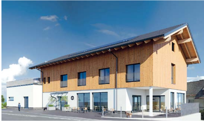
Die Umsetzung des Multifunktionsgebäudes schreitet zügig voran
